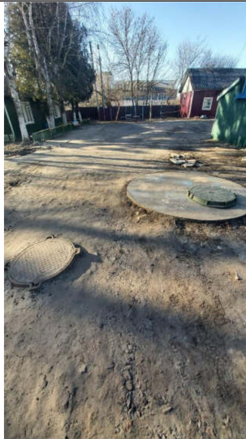
Фото № 16 Дорожное покрытие на территории объекта
