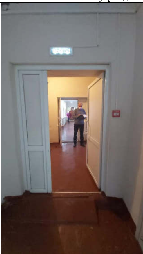
Фото № 77 Пандус у двери в коридоре на 1-м этаже
