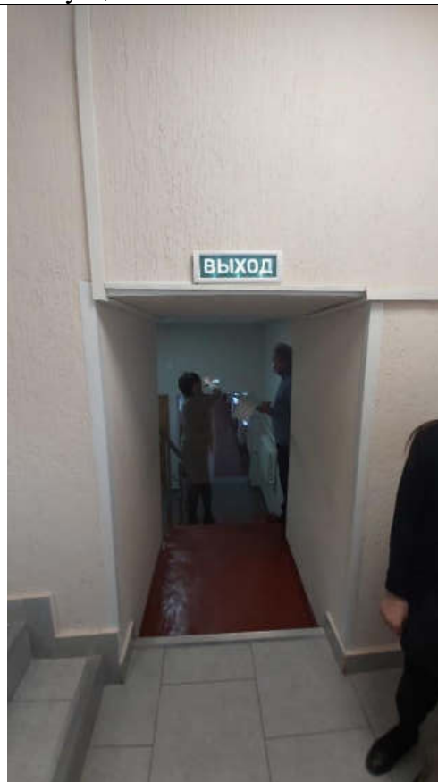
Фото № 68 Дверной проем на лестничную площадку
