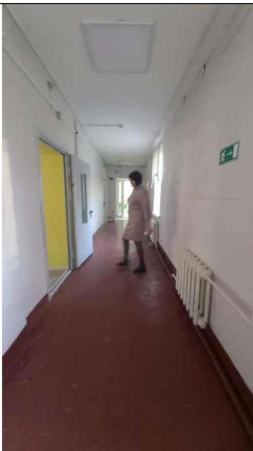
Фото № 79 Коридор 1-го этажа
