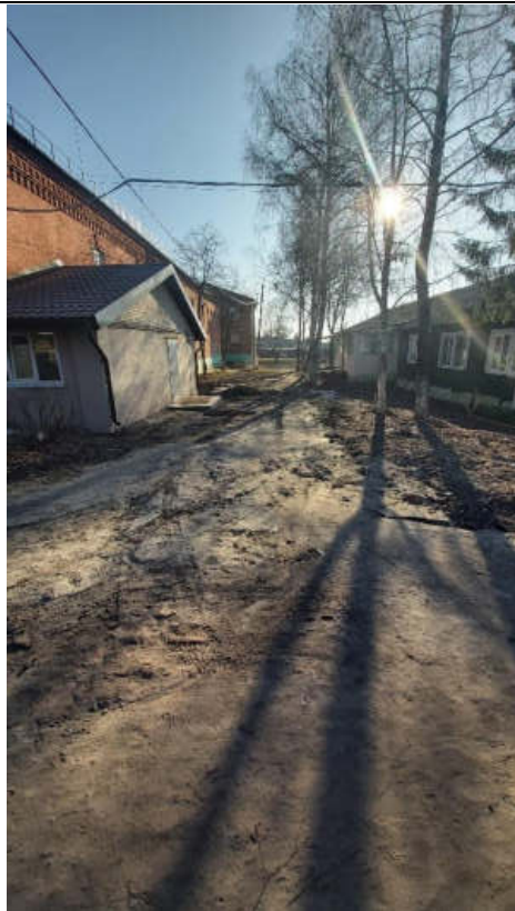
Фото № 17 Дорожное покрытие на территории объекта
