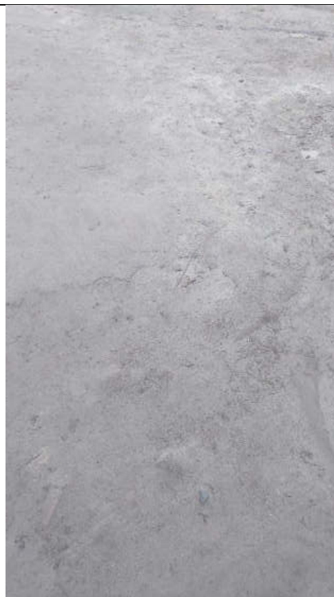
Фото № 12 Дорожное покрытие
