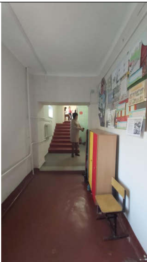
Фото № 71 Коридор 1-го этажа
