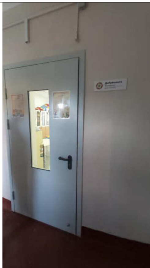
Фото № 72 Дверь в кабинет дефектолога на 1-м этаже
