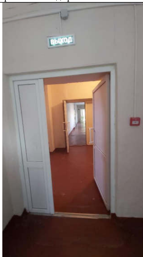
Фото № 74 Дверь в коридоре 1-го этажа
