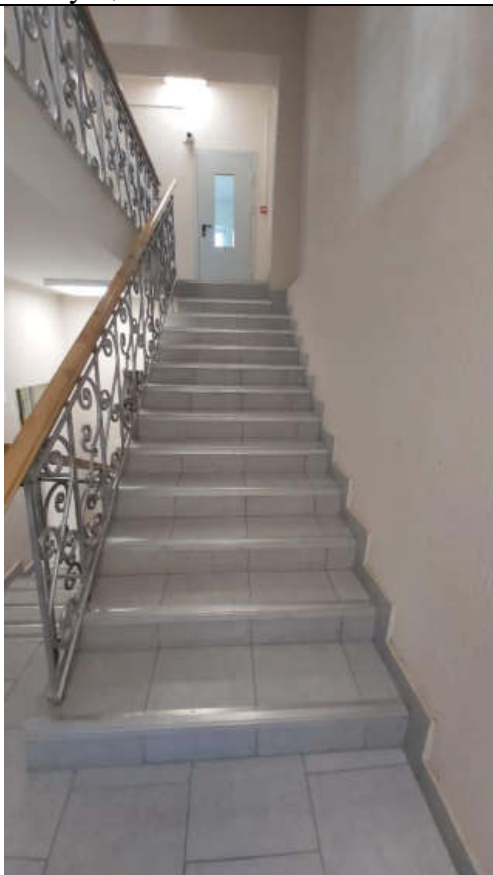
Фото № 67 Межэтажная лестница
