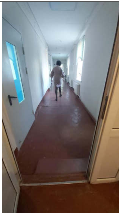
Фото № 76 Коридор 1-го этажа
