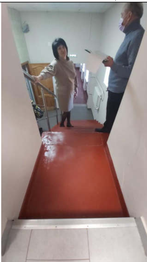
Фото № 69 Дверной проем на лестничную площадку
