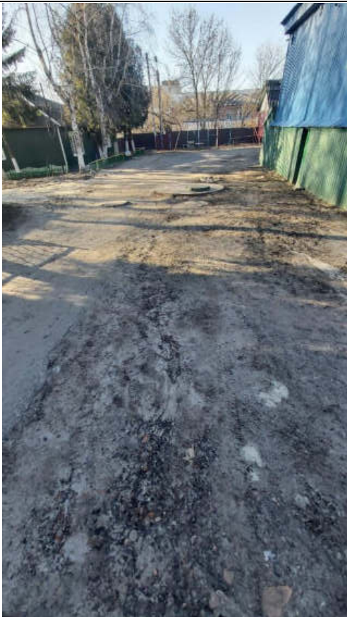
Фото № 15 Дорожное покрытие на территории объекта
