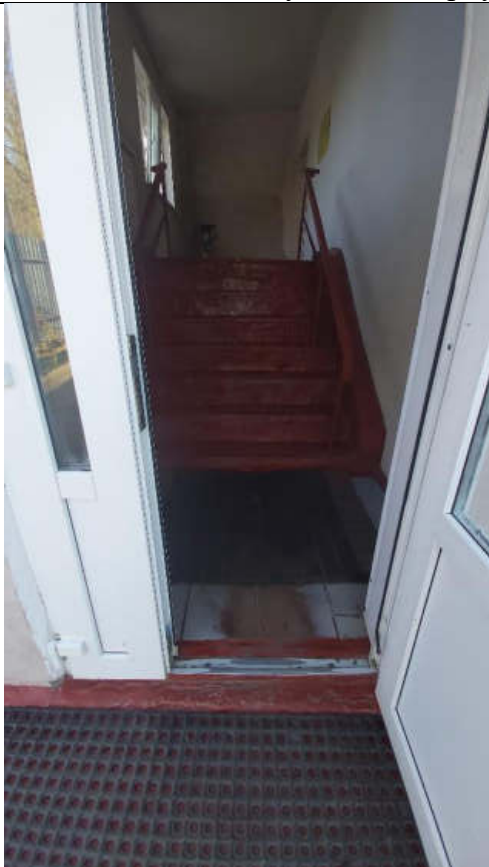
Фото № 33 Входная дверь главного входа
