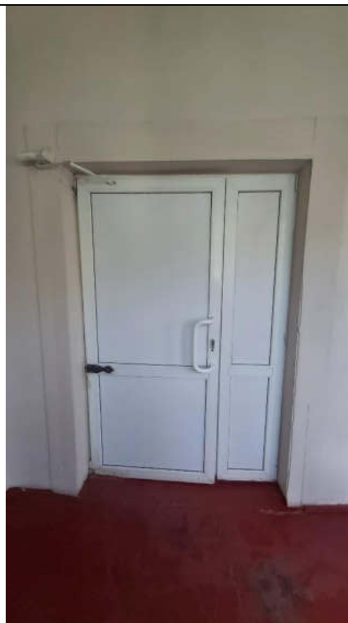
Фото № 46 Дверь из тамбура главного входа в коридор 2-го этажа
