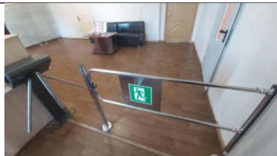
Фото № 48 Дополнительная входная секция на контрольно-пропускном пункте на 2-м этаже
