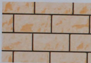
ФРАГМЕНТ КЛАДКИ, ВЫПОЛНЕННОЙ ИЗ ЦОКОЛЬНОГО ФИНСКОГО КИРПИЧА
