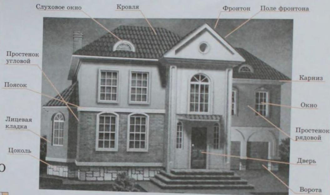
ОБЩИЙ ВИД ЗДАНИЯ
