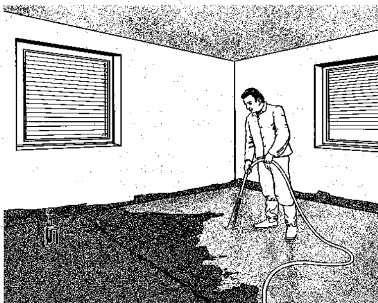
Рис. 3.16. Механизированное нанесение раствора на пол
