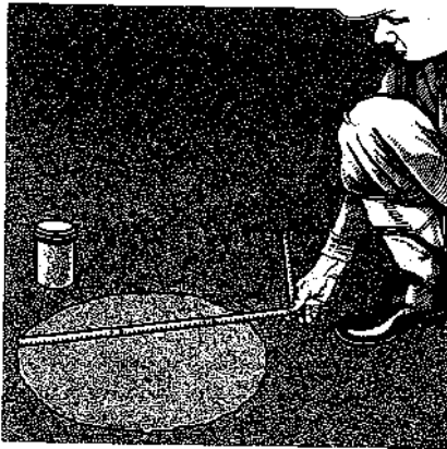
Рис. 11.5. Контроль подвижности растворной смеси наливного пола
