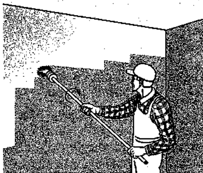
Рис. 12.2. Нанесение грунтовки маховой кистью:
