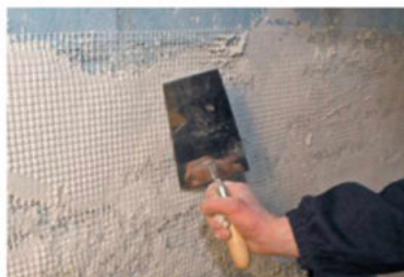
Рис. 4.2. Намазывание раствора на стену и потолок кельмой
