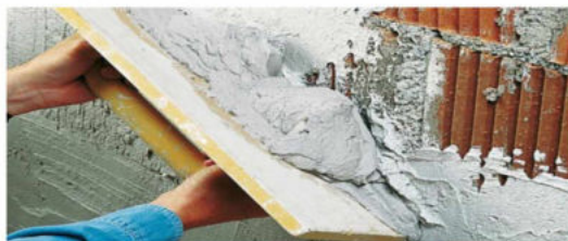
Рис. 4.1. Намазывание раствора на стену полутерком
