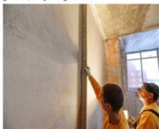
Рис. 6.2. Проверка ровности поверхности правилом
